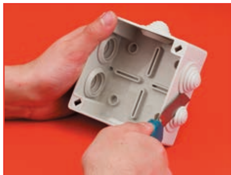
Срезаем кабельный ввод
