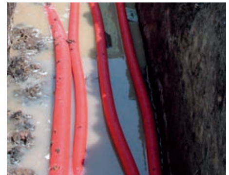
Рис.1 Применение кластеров для многорядной кабельной канализации.
