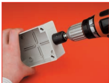
Сверлим отверстия необходимого диаметра
