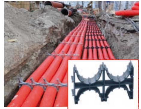
Рис.1 Применение кластеров для многорядной кабельной канализации.
