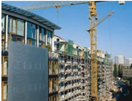
Строительство крупных торговых и складских комплексов
