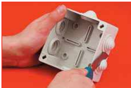
Етап 1. Зрізання кабельного вводу Step 1. Cutting off the cable gland
