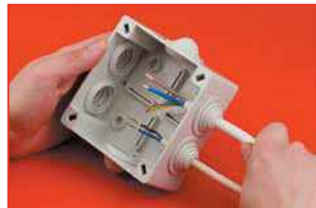
Етап 3. Введення кабелю Step 3. Insertion of cable
