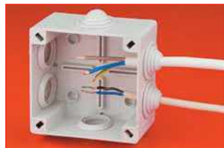
Етап 3. Введення кабелю Step 3. Insertion of cable
